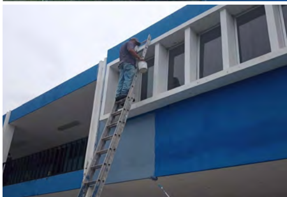
Mantenimiento de pintura en edificios de la universidad
