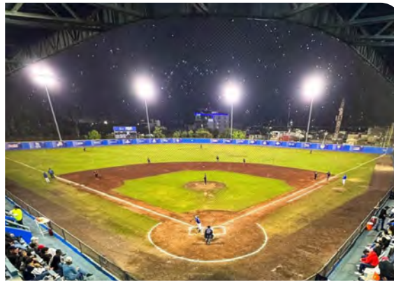
Instalación de lámparas led en Estadio de Béisbol Universitario
