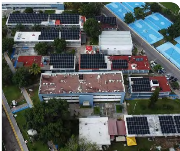
Instalación de paneles solares
